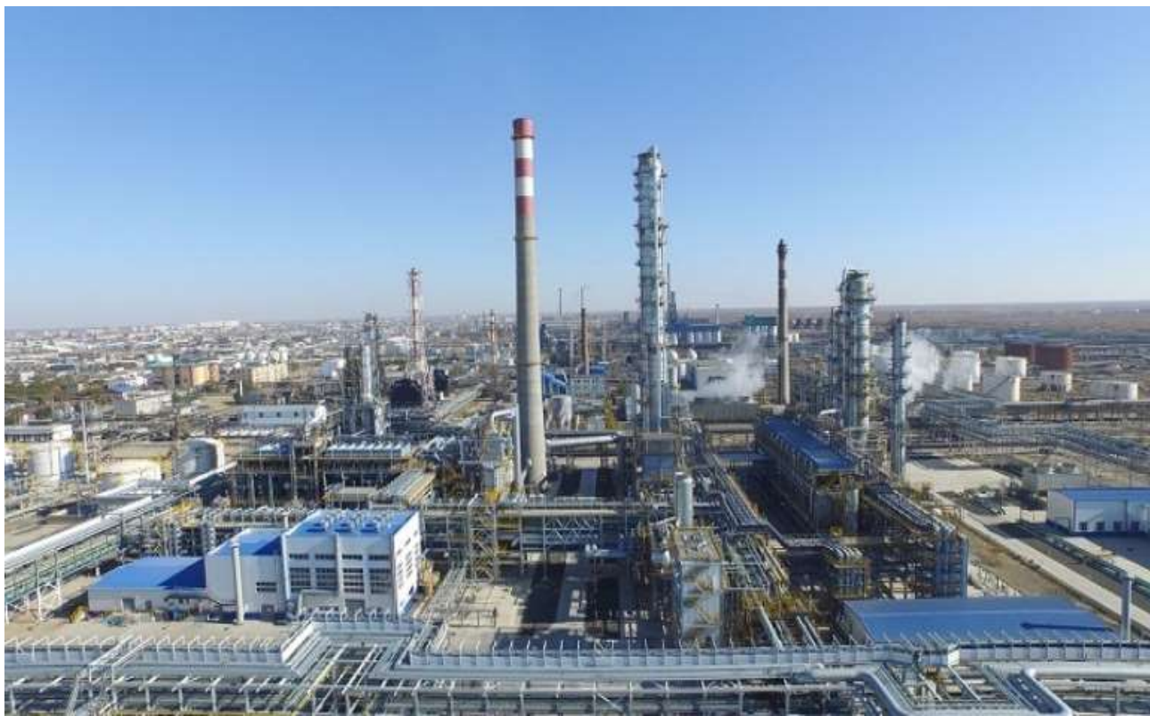
Комплекс глубокой переработки нефти ТОО «Атырауский НПЗ»
