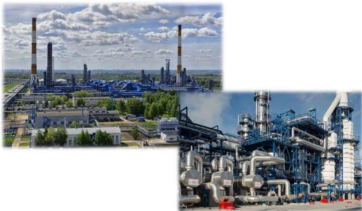
Установка производства водорода АО «Газпромнефть-ОНПЗ»
